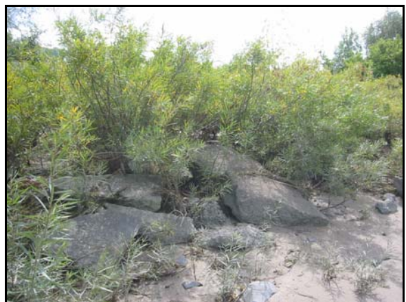
Photo 3. Lisière arbustive et blocs de béton
